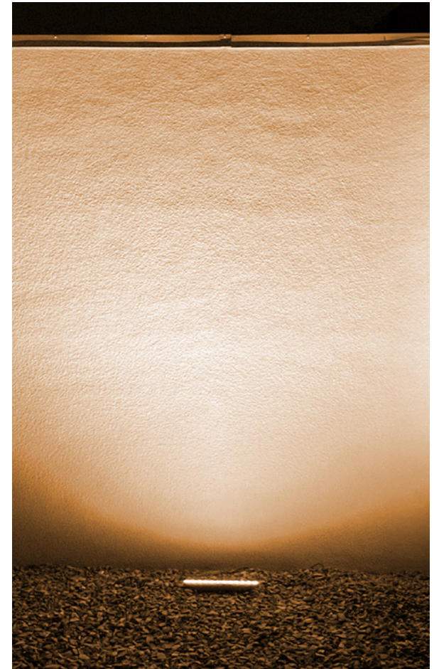
Éclairage de type « wallwash »
